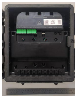
VISTA INTERNA CORPO
